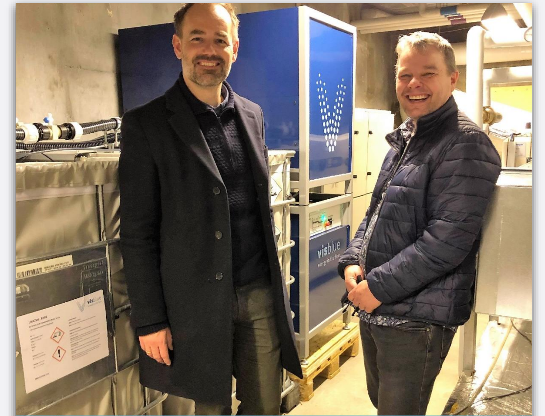
Projekt: Mårslet skole Størrelse: 10kW@100kWh
