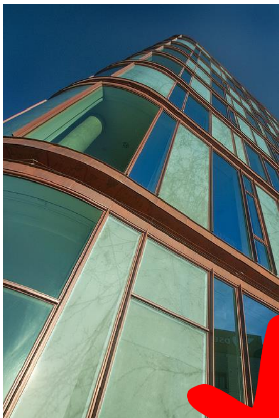
Vinduer med belægning og høje niveauer af jern
